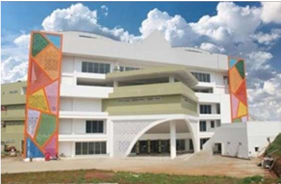
Gambar 1 Gedung Cendekia UMJ
